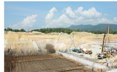
Besut Barrage, Terengganu
